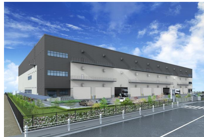
西多摩郡青梅ロジ (物流施設、建築中)
