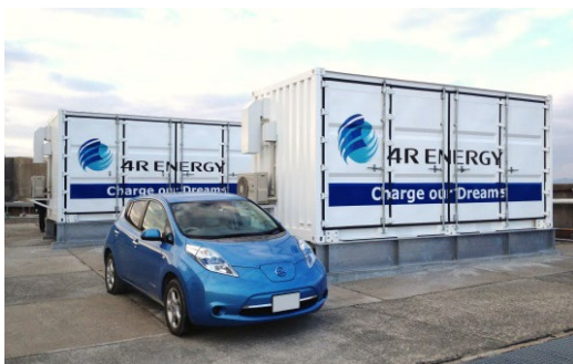
リユース蓄電池の活用
