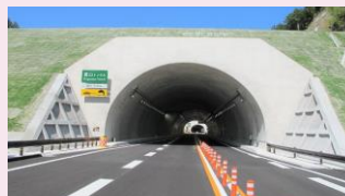
トンネル建設工事
