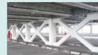
耐震補強（コクドビルエース）
