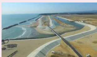
河川堤防工事
